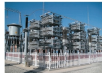
TBB系列并联电容器装置
